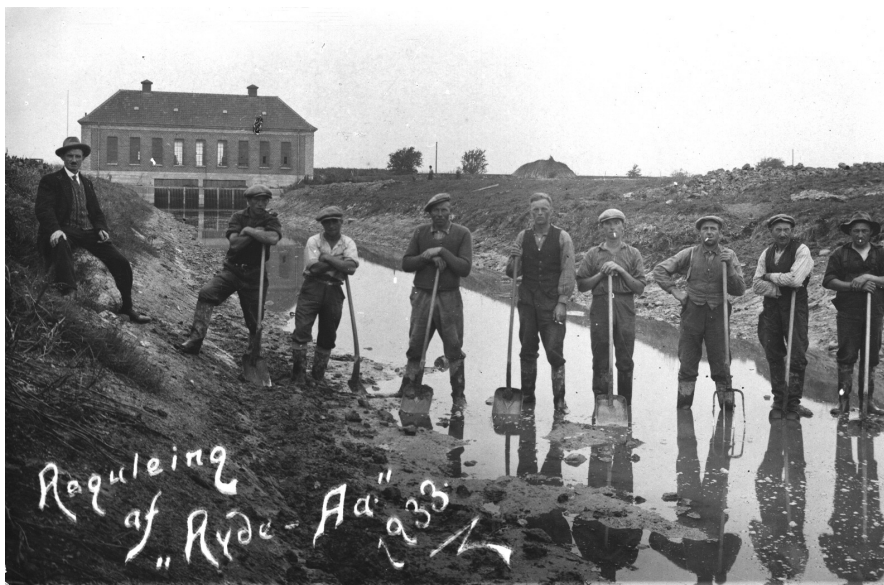
Figur 2: Billede fra Højreby Lokalhistoriske Arkiv med udgravningen af pumpekanalen til Ryde Å Pumpestation tilbage i 1933.
